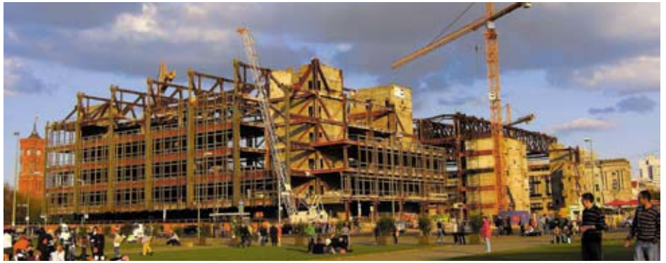
Der Palast des Volkes in Berlin war wohl weltweit der bekannteste Asbestsanierungsfall.
